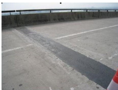
无缝式伸缩缝
