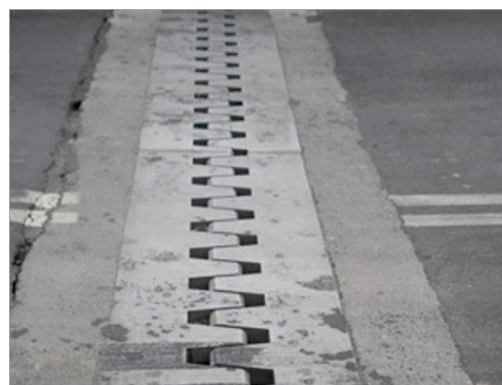
梳齿板式伸缩缝
